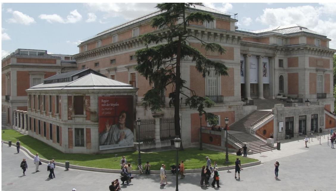
Edificio Villanueva, Museo del Prado. Actual puerta de Goya
